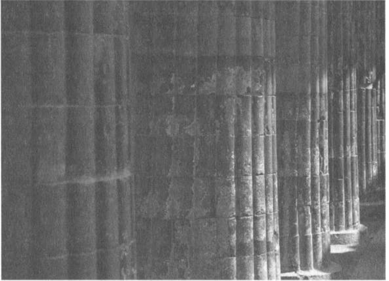
Diyoser kompleksinin kolonlu girişi. Hurma ağacı kütüklerinden tavana ve kamış sütunların dışbükey yivli ve deri başlıklı taklitlerine dikkat edin (after J.-P. Lauer, 1936, pl. XLV).
